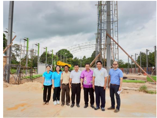
โรงคลุมเครื่องจักร (อยู่ระหว่างการก่อสร้าง) จ.ศรีสะเกษ
