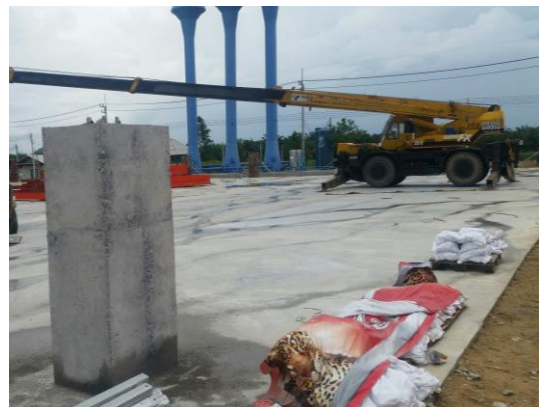
โรงเรือนอเนกประสงค์รองรับการผลิตยางแท่ง STR20 (อยู่ระหว่างการก่อสร้าง) จ.ชลบุรี
