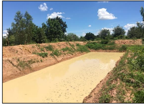
การจัดระบบฯ โดยการทำบ่อดักตะกอน
